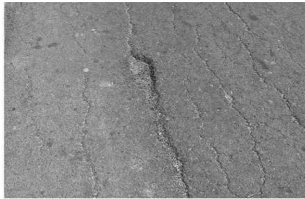
**Fig 4. Longitudinal Cracking**
