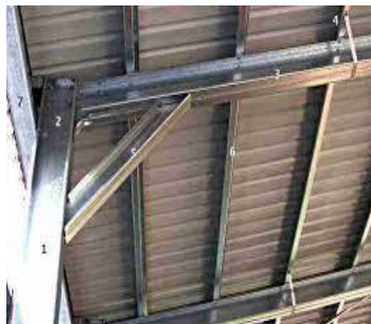
Fig.1. Knee bracing
