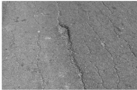
**Fig 4. Longitudinal Cracking**
